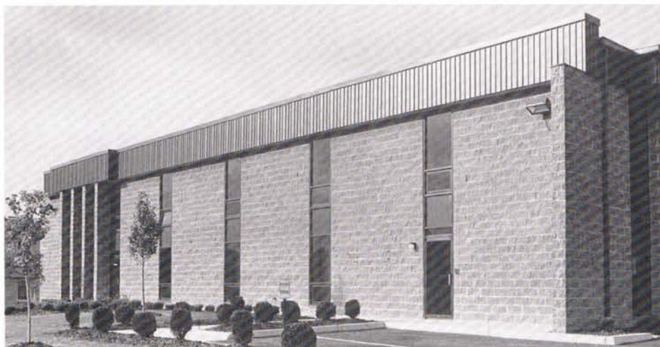
Geschäftssitz und Fertigung von Surface Technology, Inc.
